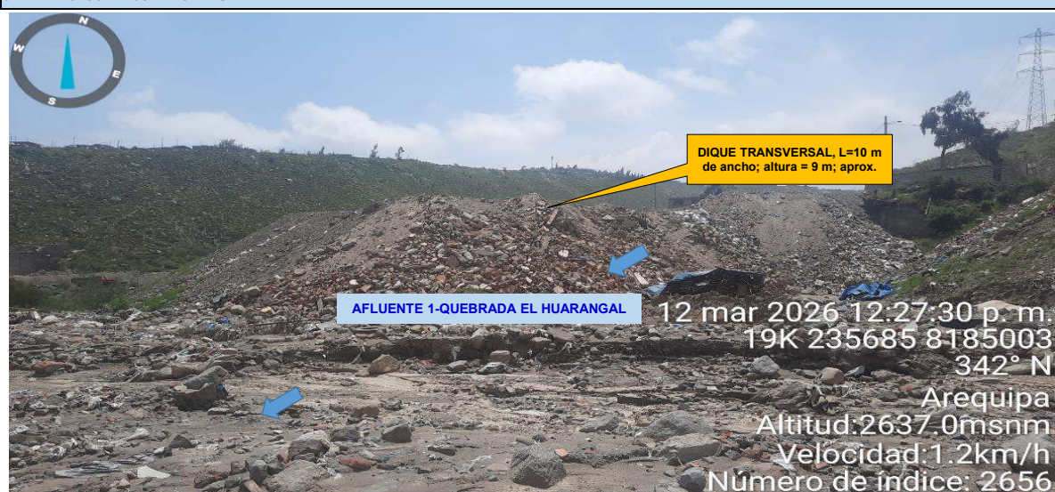
Imagen N° 1. Tramo donde se observa un dique transversal en el cauce del afluente 1-Quebrada El Huarangal.
